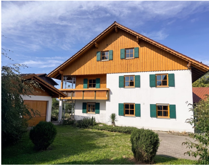
Giebelseite mit Balkon und Doppelgarage
