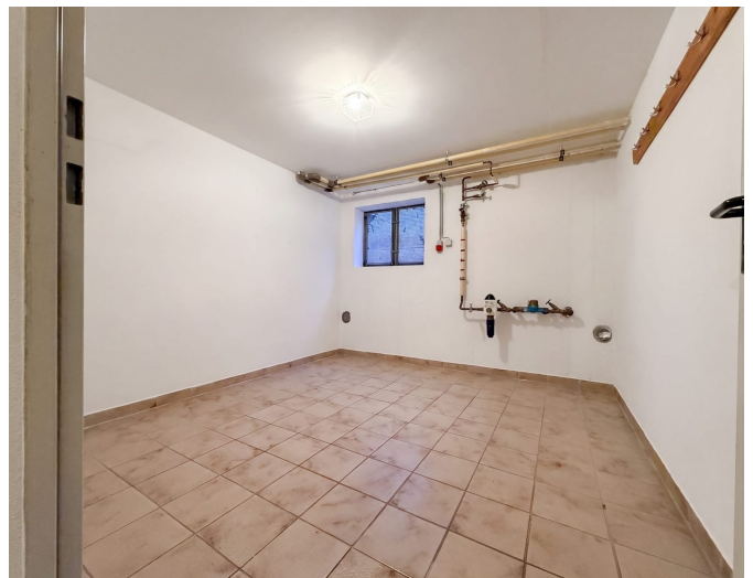
Keller: zweiter Kellerraum
