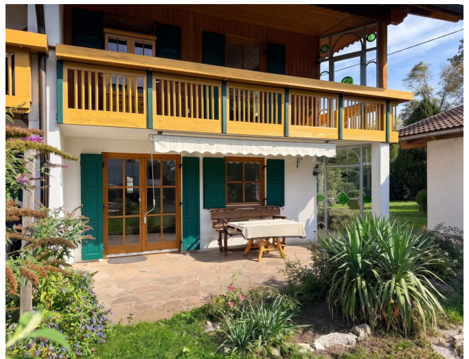
Terrasse mit Markise, darüber der Südbalkon
