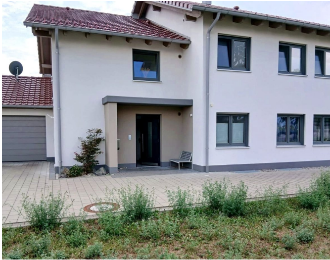
Straßenseite mit Garage
